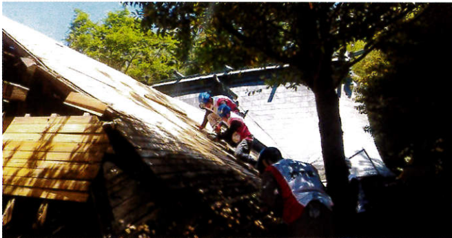
社殿修復作業の様子
